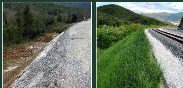
Rilevati in terreni granulari – San Vincenzo (LI) Toscana
